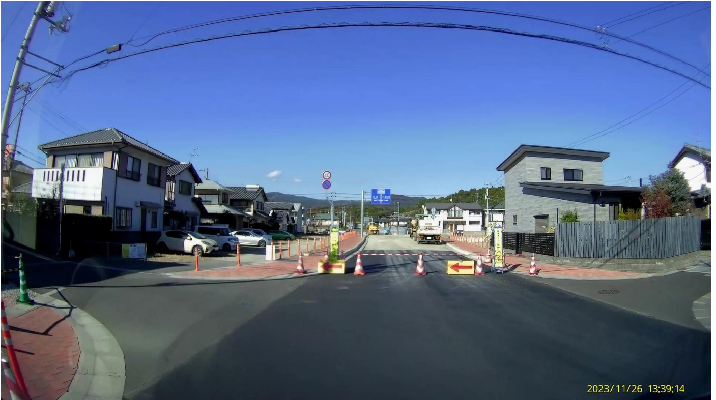
撮影地・高知県香美市土佐山田町秦山町 未開通の一部分に舗装されました。
